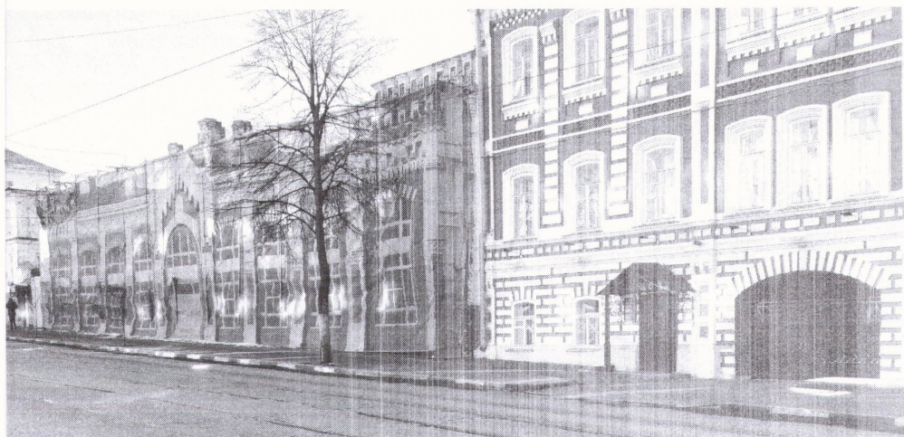
Главный (северный) фасад.
